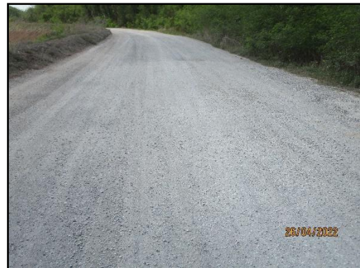
ภาพที่ 2.6 ถนนหินคลุกบดอัดแน่นภายในพื้นที่โครงการ
