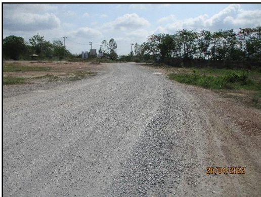
ภาพที่ 2.6 ถนนหินคลุกบดอัดแน่นภายในพื้นที่โครงการ
